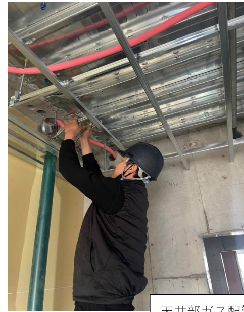
天井部ガス配管工事中
